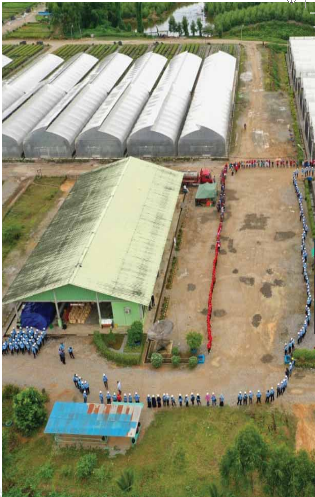
Gambar 6.9. Pembangunan persemaian modern Mentawir untuk penghijauan di lokasi proyek IKN Sumber: PPID KLHK 2021
